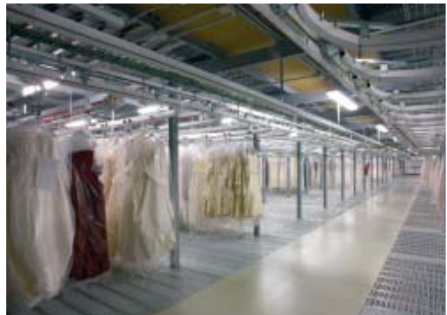
La entreplanta, en este caso de varios niveles, se destina a zona de clasificación y almacenaje de prendas de vestir colgadas. La propia estructura soporta además los elementos de rodadura de los carros con las prendas.
